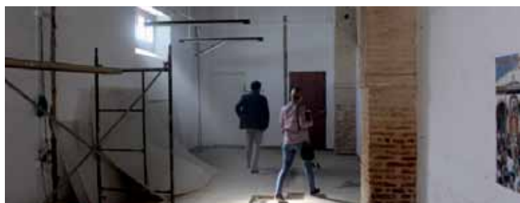
Obras para la creación de la Casa de la Juventud
