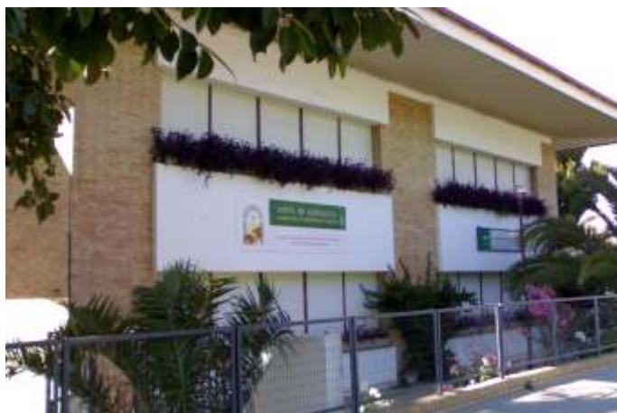
Remodelación y adaptación de los Centros Escolares. 3.841.362 € . Consejería de Educación de la Junta de Andalucía.
