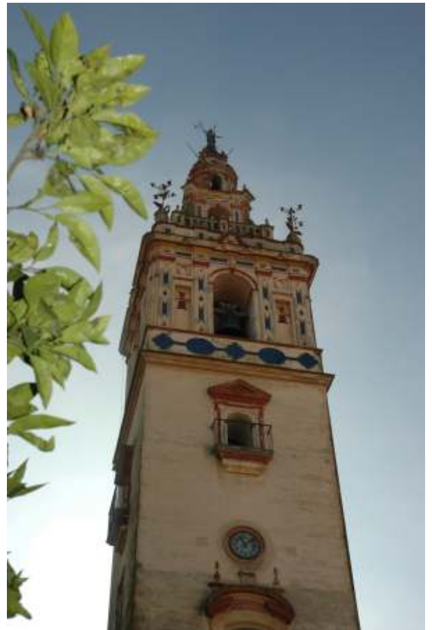
Finalizado redacción del proyecto de la restauración de la Iglesia
