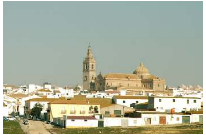
Rehabilitación de viviendas. 1.506.382 € Consejería de Obras Públicas de la Junta de Andalucía.
