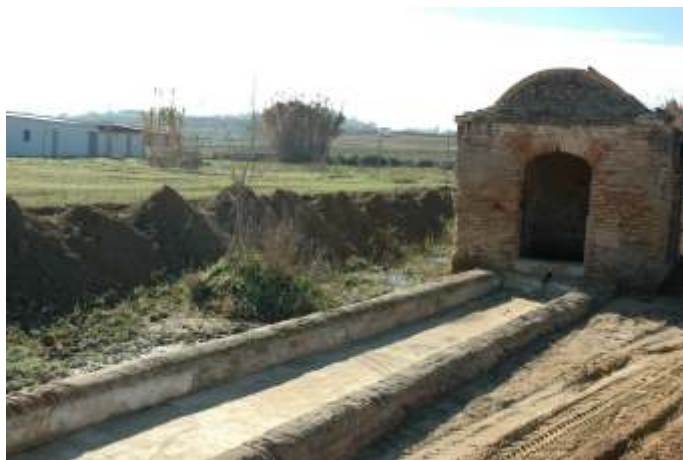
Actuaciones en materia de infraestructuras y dotaciones medioambientales. 2.725.688 € . Consejería de Medio Ambiente de la Junta de Andalucía.
